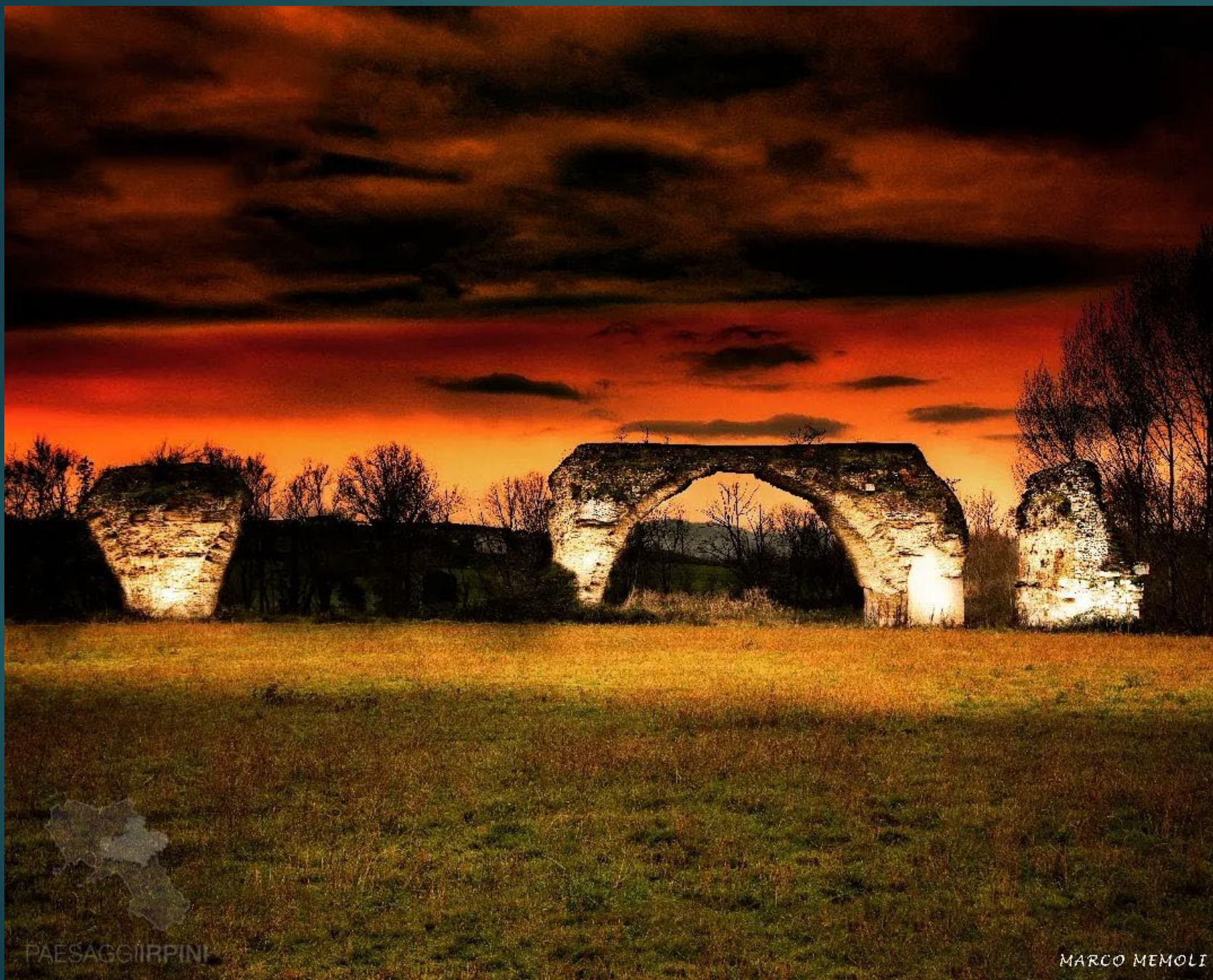
Comune di Venticano (AV): Ponte rotto lungo la Via Appia
